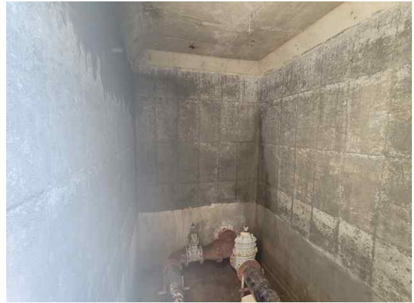
손상내용 통합유출밸브실 전면 벽체 상태양호 손상원인 -
