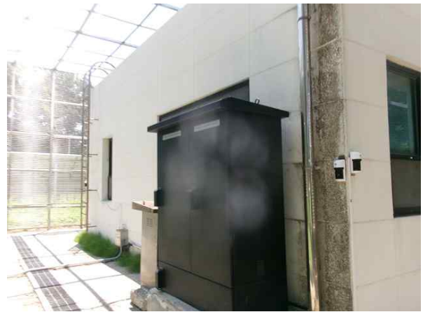
손상내용 검수실 외부 전기설비 상태양호 손상원인 -
