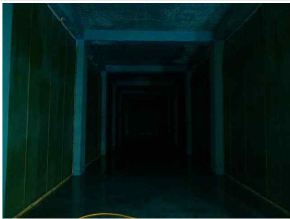
배수지 1지 내부 전경
