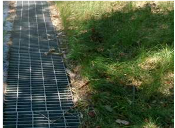
손상내용 배수지 주변 사면 토사유실(상태양호)
