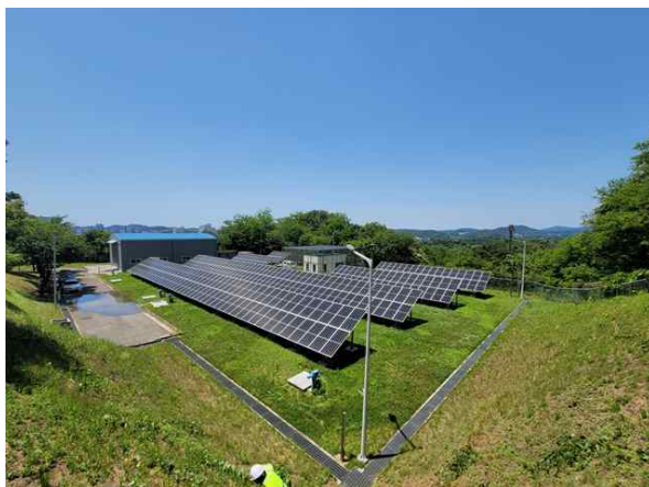
배수지 상부 현황
