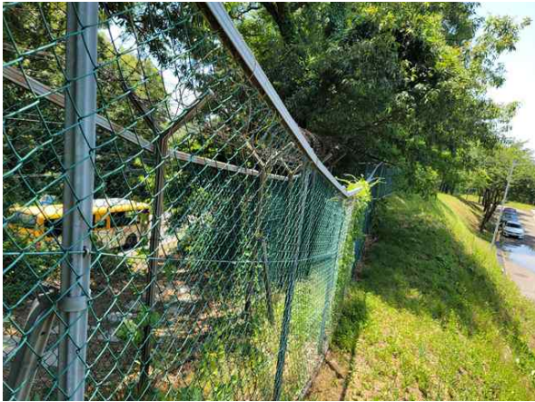
손상내용 안전휀스 상태양호
