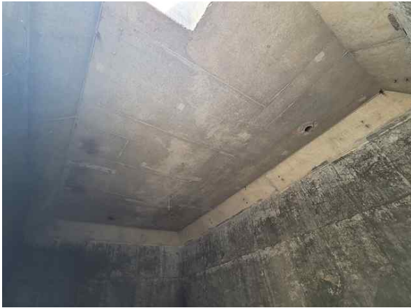
손상내용 유량계실 상부슬래브 상태양호 손상원인 -
