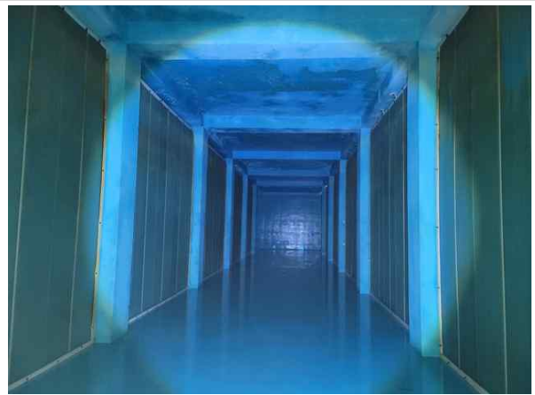
배수지 2지 내부 전경
