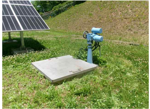
환기구 등의 덮개(장비 반입구) 현황
